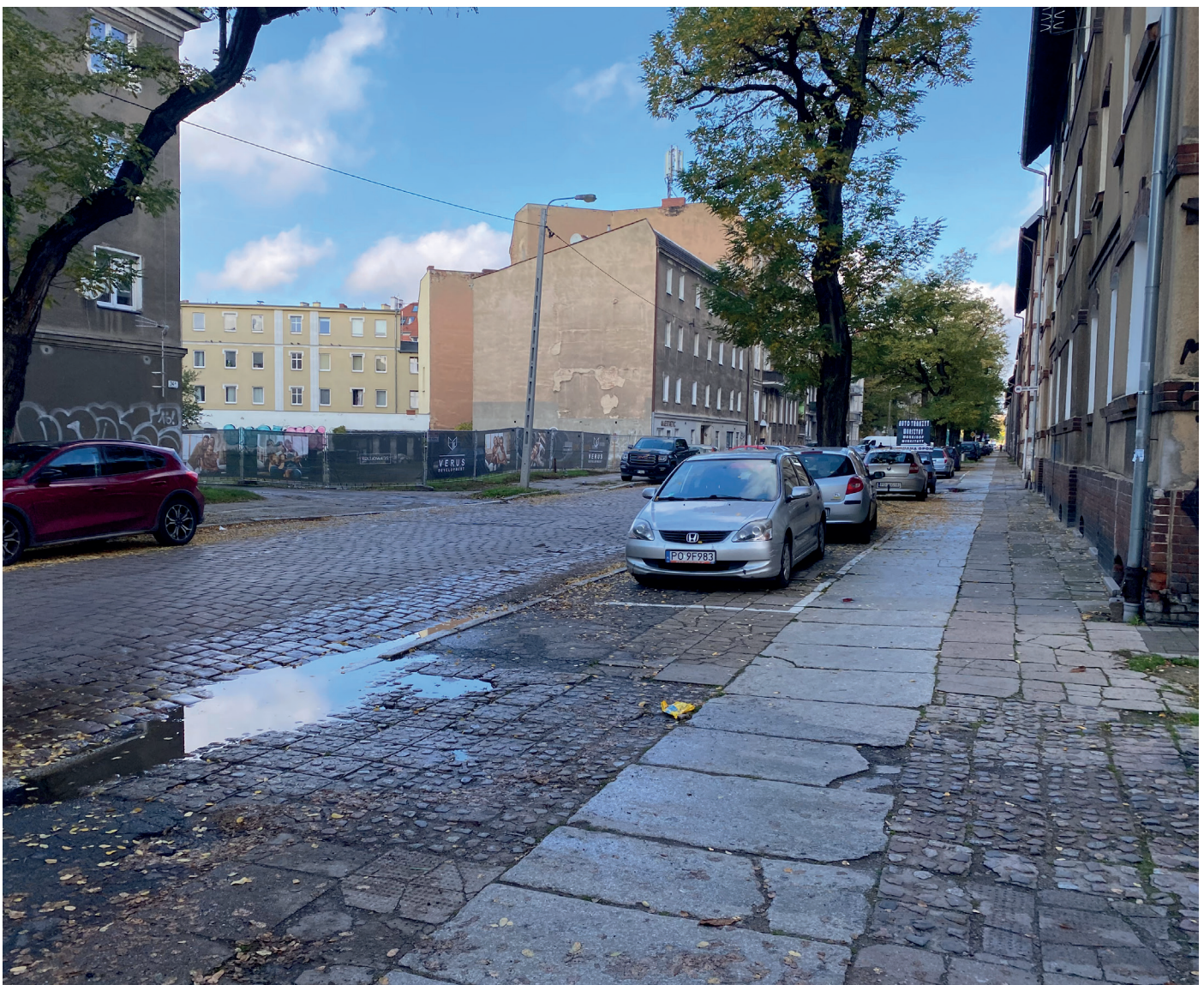
Ul. Kolejowa przed przebudową. Widoczna na jezdni kostka w całości pozostanie na ulicy – pod miejscami parkingowymi i między chodnikiem a pasem zieleni. Fot. A. Janowski
