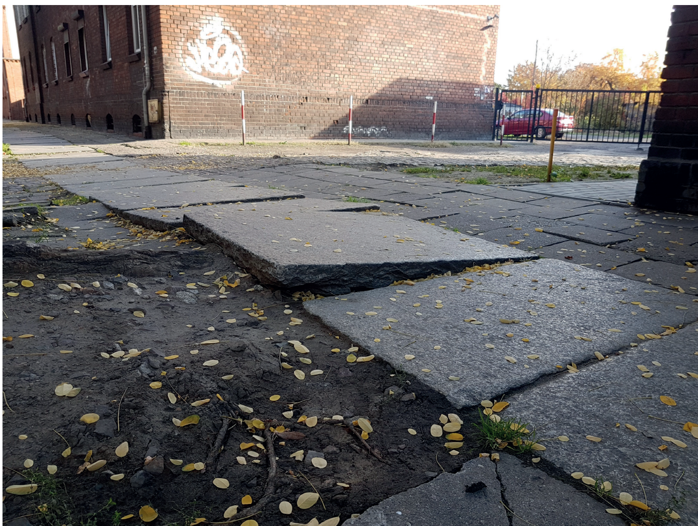
Granitowe płyty zostaną wykorzystane do budowy chodnika. Fot. A. Janowski
